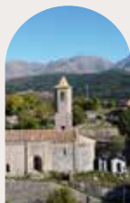
01 SANTA MARIA DE VIU DE LLEVATA EL PONT DE SUERT Pàg. 08
